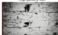
Viditelné stopy po přerušení obrábění - nepřijatelný stav
